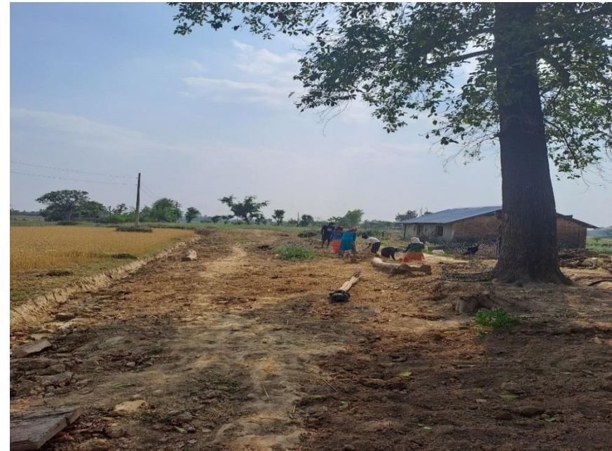
कामका लागि पारिश्रमिक वडा नं ४ बाटो ट्याक निर्माण
