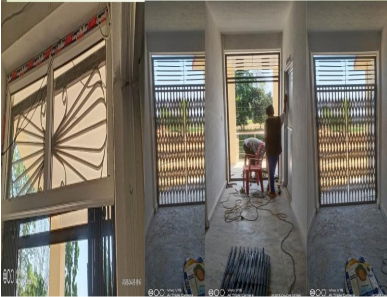
२ वटा च्यानल गेट र २ वटा भन्टिलेटर निर्माण विनियोजित रकम रु ९००००
