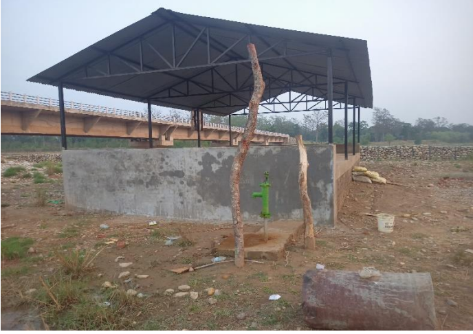
शवदाहस्थल नजिकै निर्माण गरिएको विश्रामस्थल (ठाकुरबाबा-६, ओरही खोला पुल नजिक)
