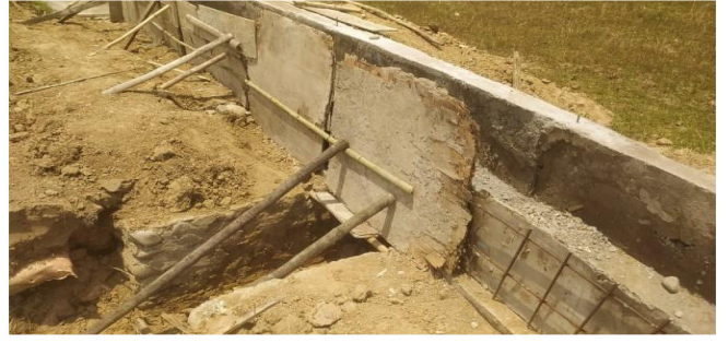
राजु थारको घर नजिक कुलो वाल निर्माण रु. ७००००/
