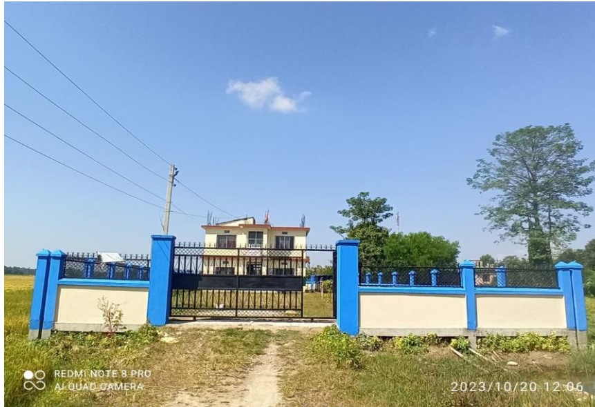
वडाहरुको पर्खाल निर्माण
