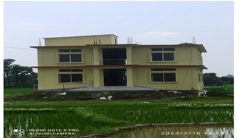
वडा नं ९ कार्यालयको भवन निर्माण
