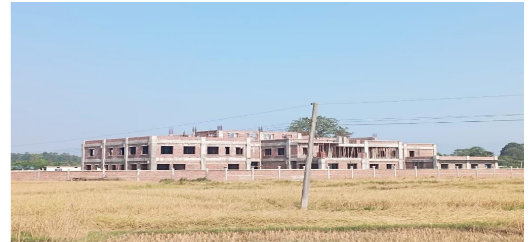
१५ शैय्याको नगर अस्पताल भवन निर्माण (७०% काम सम्पन्न भएको)
