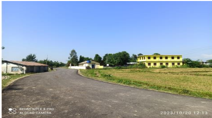
गिदरपुर-मिर्चैया-नेउलापुर-मानपुर सडक निर्माण
