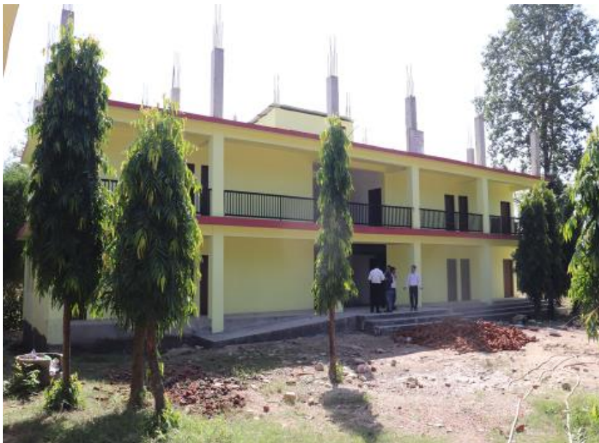
नेपाल राष्ट्रिय मा बि कर्मला भवन निर्माण
